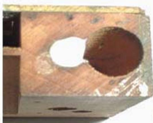
2. ボンドが奥まで行きわたるよう、爪楊枝でボンドを押し込むようにする。
